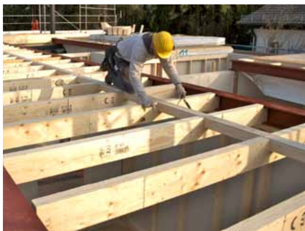
STEICO LVL R w konstrukcji stropu.
